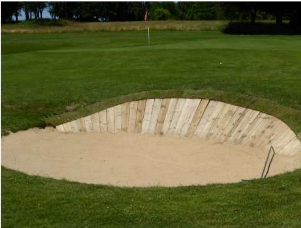
Der Bunker an der Spielbahn drei war besonders gefährdet und drohte abzurutschen. Durch Einsatz der Holzplanken kann das in Zukunft ausgeschlossen werden.
