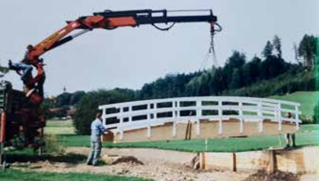
Die Brücke am 5. Loch wird montiert
